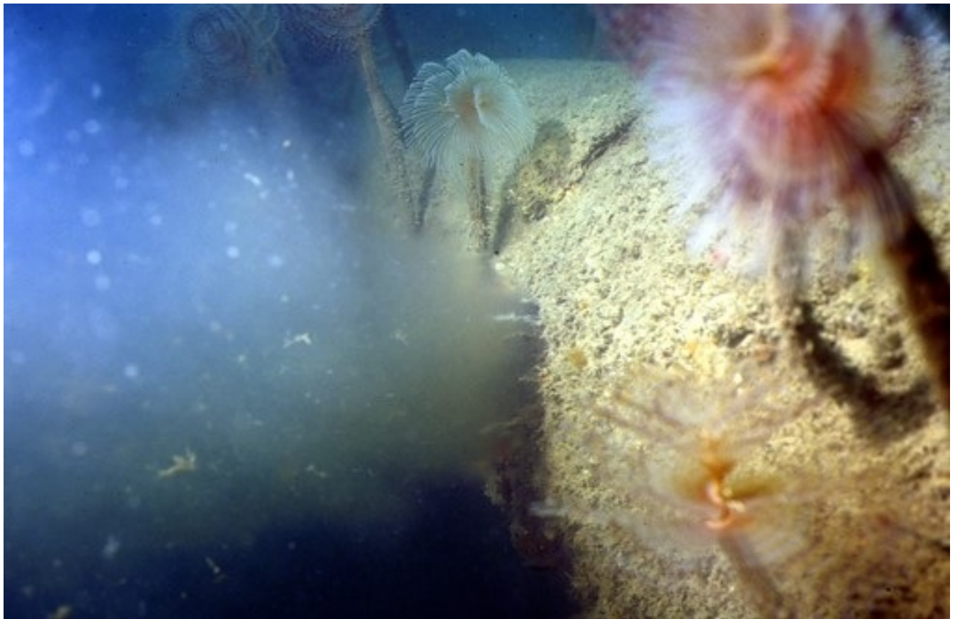
Slika prikazuje izpust odpadne vode iz podvodnega cevovoda čistilne naprave Piran. Centralna čistilna naprava Piran prečiščeno odpadno vodo odvaja preko dveh podvodnih izpustov dolžine 3600 m in 3450 m, ki imata na koncu difuzor. Foto: Tihomir Makovec
